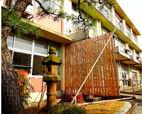
冬の季節風が直接玄関に当たらない ように設置されたフェンス
